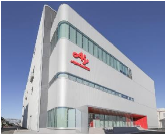
新「ほんだし®」工場 (2020年10月稼働開始)
