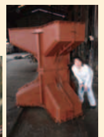
消波ブロックの型枠
