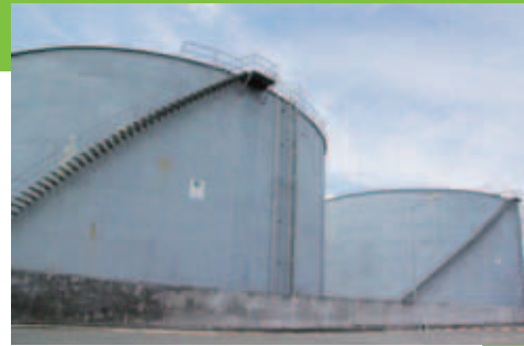
液体肥料を保管するタンク（ベトナム）
