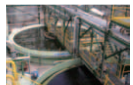
BDNおよび凝集沈殿設備 (ベトナム味の素社)
