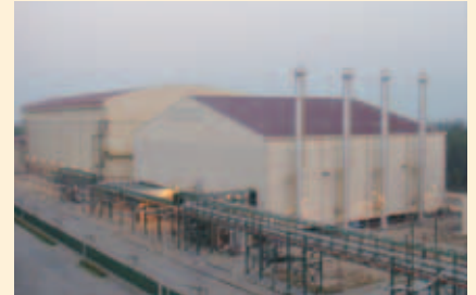
約1カ月分、1万トンのもみ殻が貯蔵できる巨大なサイロ（写真奥）とボイラー（手前）
