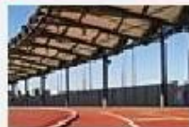
屋根付トラック
