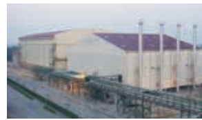
約1か月分 (10,000トン) のもみ殻が貯蔵できる巨大なサイロ (写真奥) とボイラー (手前)
