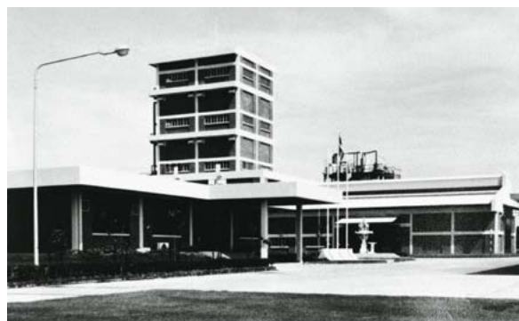
タイ味の素社パトンタニ工場(竣工当時)
