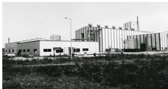
ハートランドリジン社工場(竣工当時)
