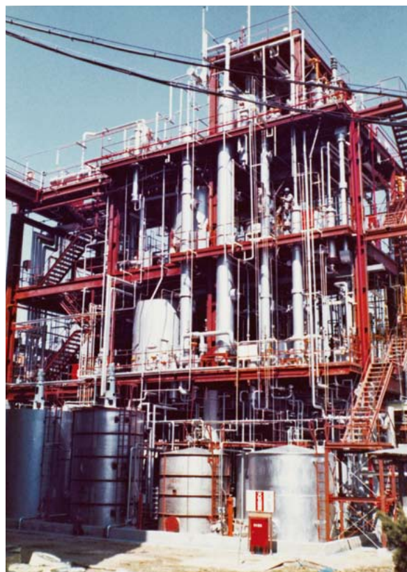
アスパルテーム製造設備
