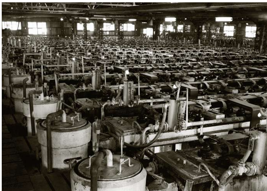
増設された電解槽
