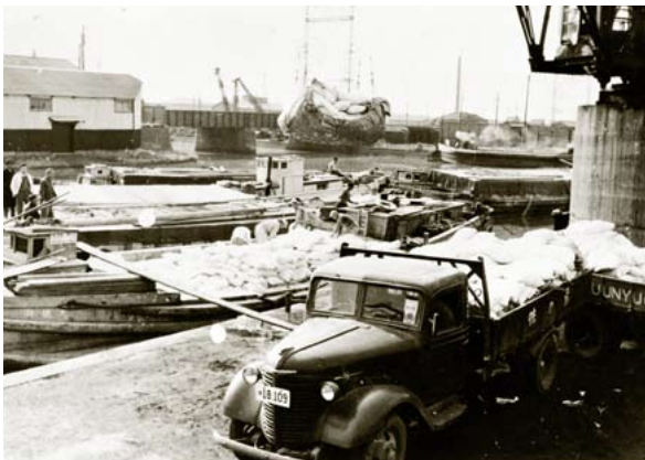
原料小麦粉の荷揚げ風景(1950年12月、川崎工場)
