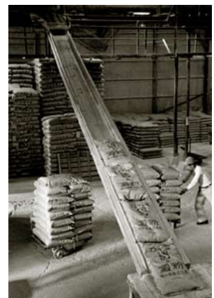
澱粉の製品倉庫
