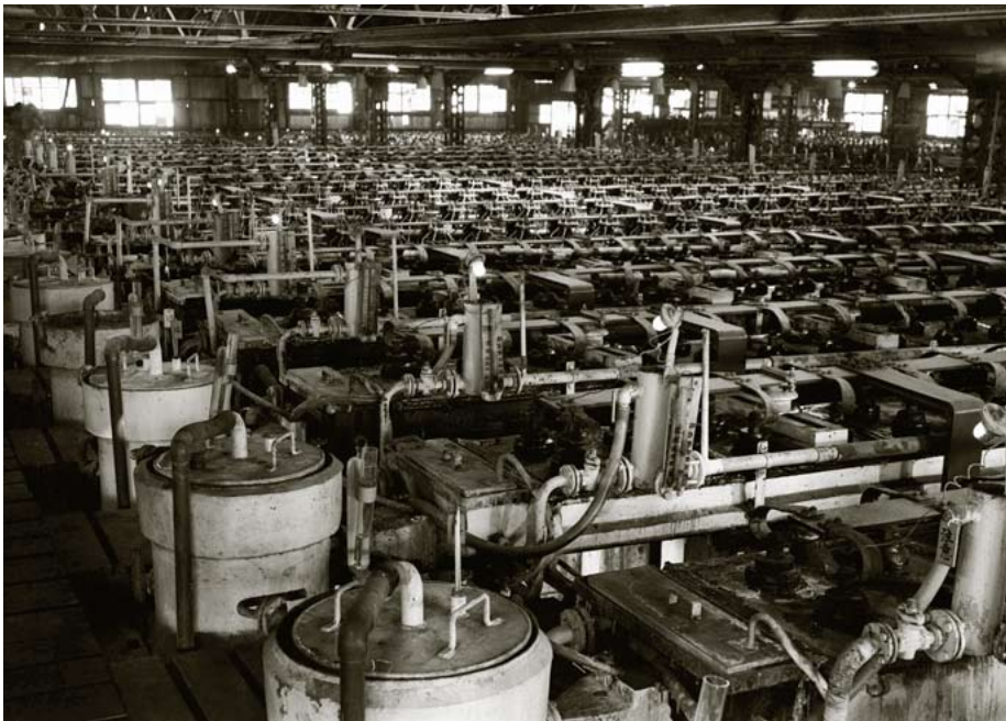
増設された電解槽
