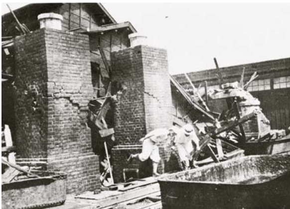
震災で倒壊した川崎工場
